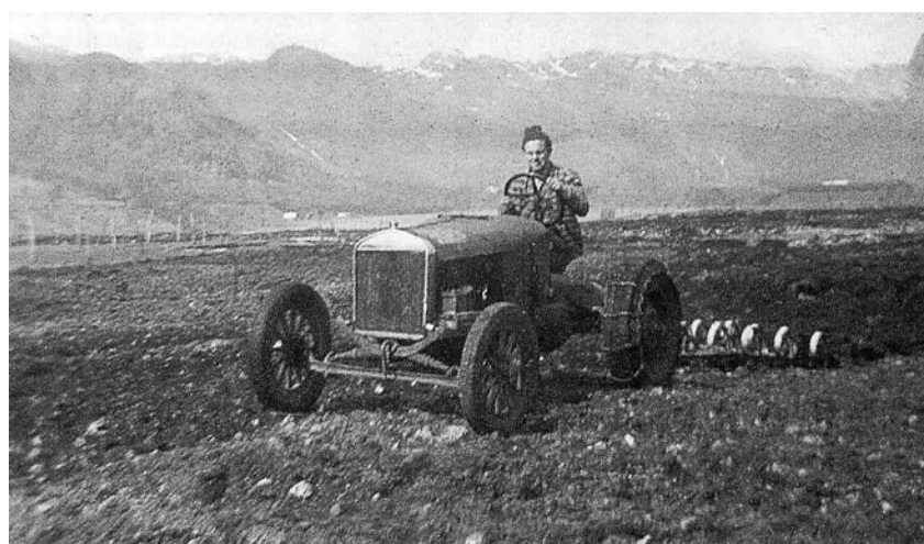
Ivar P. Espeland hadde laga traktor av deler han kjøpte av en biloppfogger i Stavanger.
